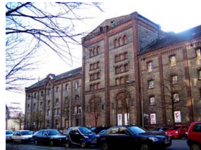
Ansicht Richard-Sorge Straße
